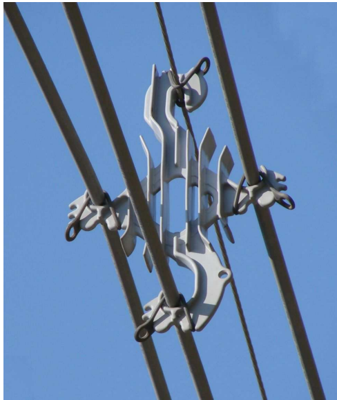
Figura 4 - Espaçador losangular em rede compacta
