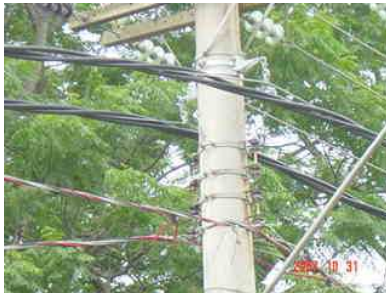
Figura 8 - Rede isolada de média tensão
