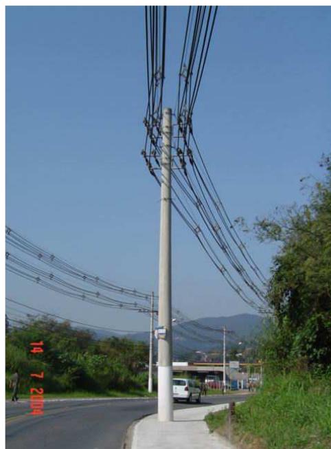
Figura 7 - Circuitos múltiplos de rede compacta
