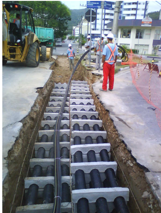
Figura 9 - Banco de dutos em rede subterrânea
