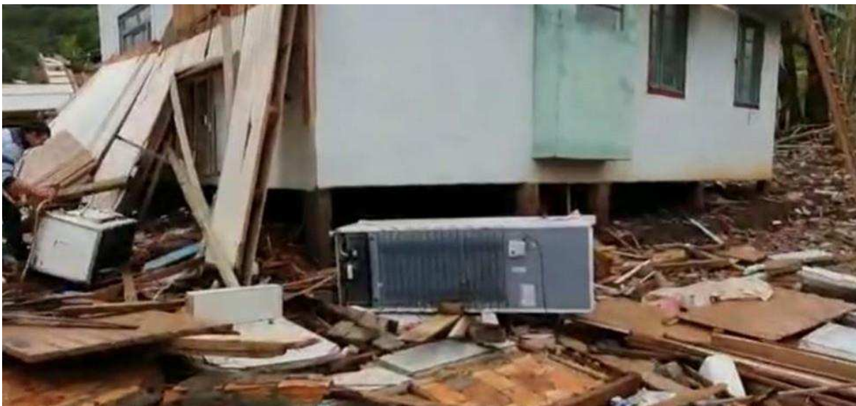
Casas destruídas em Água Doce após tornado — Foto: Reprodução/ NSC TV
