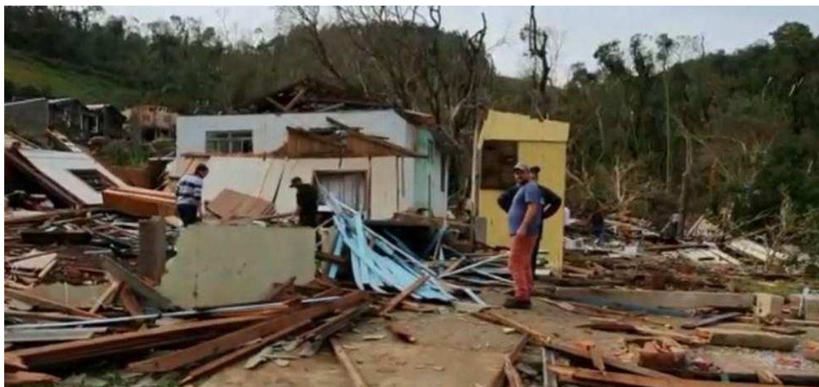
No total, 25 famílias tiveram a casa totalmente destruída com o tornado — Foto: Reprodução/ NSC TV
