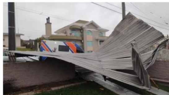
Destelhamento na cidade de Xanxerê, em Santa Catarina Defesa Civil SC/Divulgação
