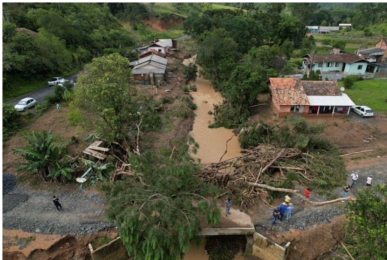
Chuva castigou a localidade de Três Barras, inundando casas e destruindo pontes – Defesa Civil Ituporanga / Divulgação /
