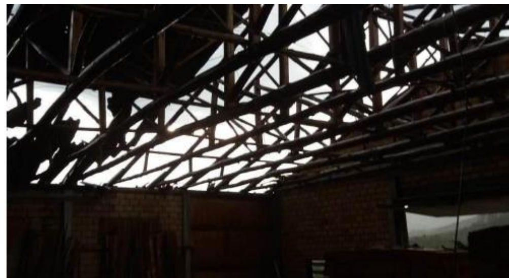
Rajadas de ventos causaram destelhamentos no fim da tarde de segunda-feira. (Foto: Defesa Civil de Santa Catarina)
