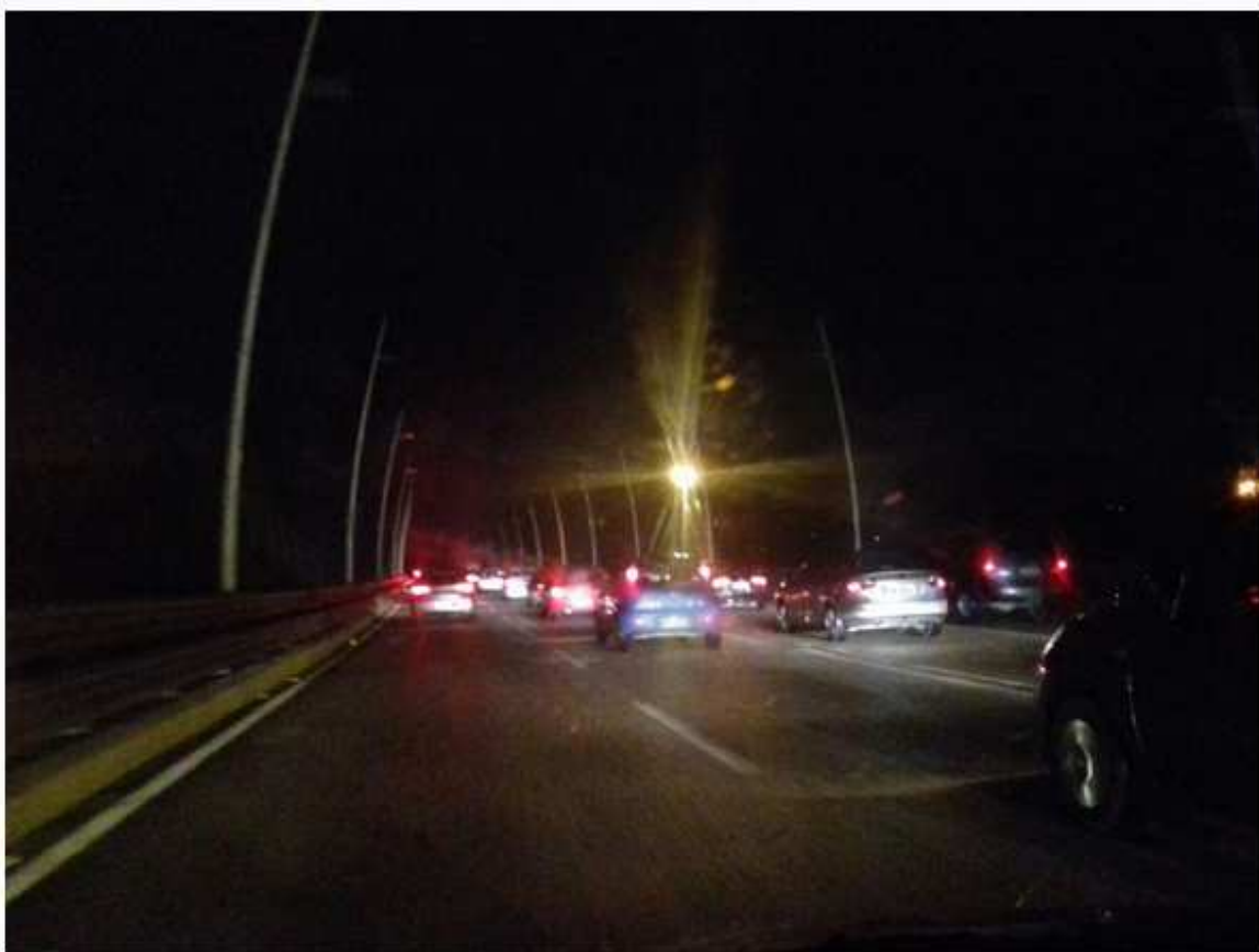
Ponte Colombo Salles teve queda de luz - ND
