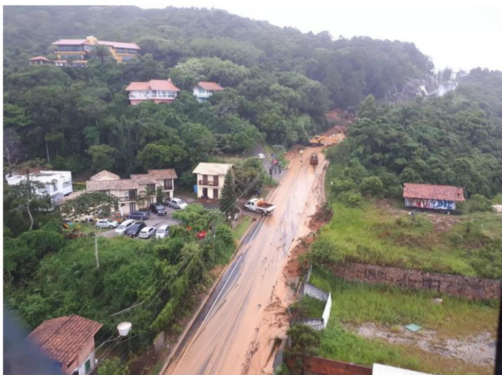
SC-405 na Base da Lagoa teve interdição após queda de barragem na rodovia (foto: Evandro Frazão/NSC, TV)
