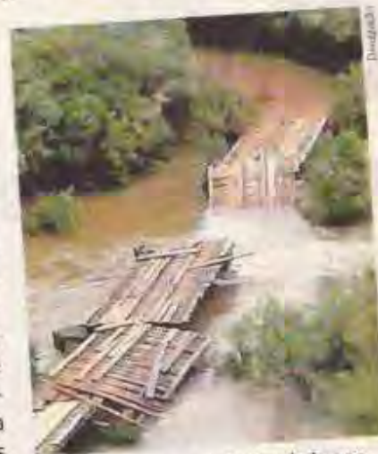
São 56 pontes no interior de Lages
