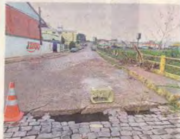
Na Rua Alfredo Konder, no Bairro Sagrado Coração de Jesus, o Rio Passo Fundo subiu e causou estrago na via. O buraco tem mais de um metro de profundidade.
